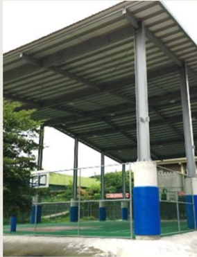
半戶外球場 (風雨球場、風雨操場) 以浪板或薄膜為屋頂
